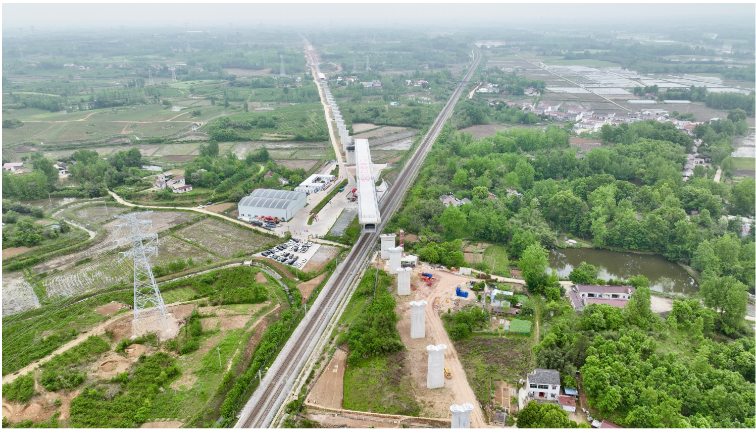
4月21日拍摄的合武高铁跨宁西铁路万吨连续梁转体施工现场(无人机照片)。
