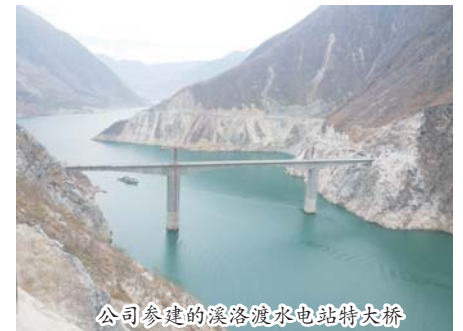
公司参建的溪洛渡水电站特大桥
