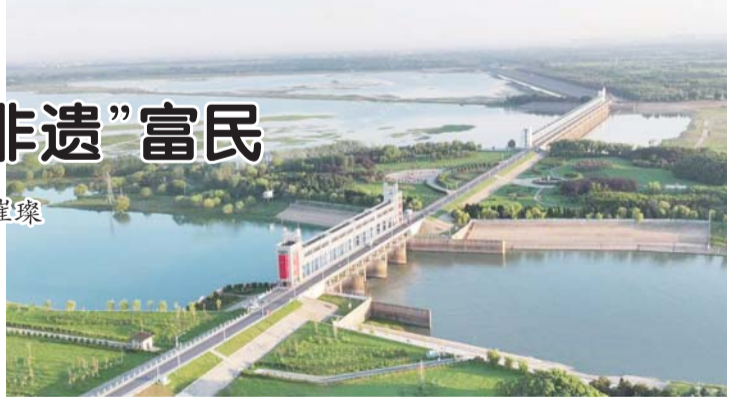
在霍邱县的临淮岗洪水控制工程现场，一座宏伟壮观的水闸如巨龙般横跨水面，气势恢宏。 刘国有 摄
