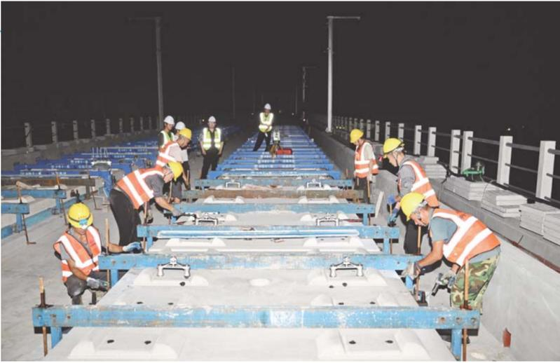
8月20日，中铁十一局工人在雄商高铁站前六标段无砟轨道施工现场作业。目前，经过中铁十一局等单位参建者艰苦奋斗，雄商高铁河北段无砟轨道施工进度顺利，为后期主线铺轨工作奠定基础。雄商高铁是我国高速铁路网“八纵八横”之京港（台）通道的重要组成部分，正线全长552公里，设计时速350公里。
