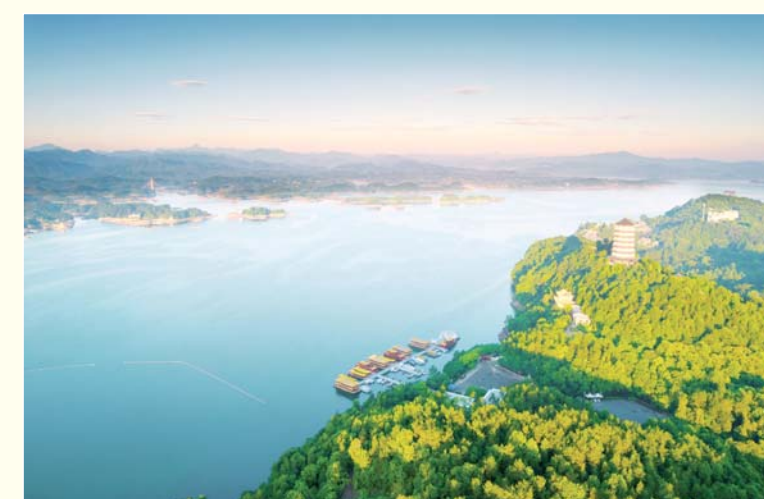
舒城县龙河口水库
