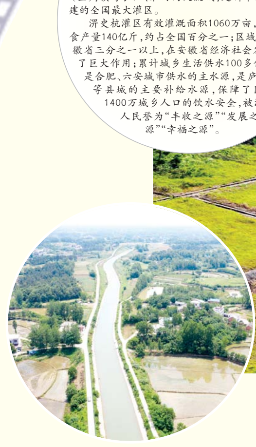
河南省固始县南干渠
