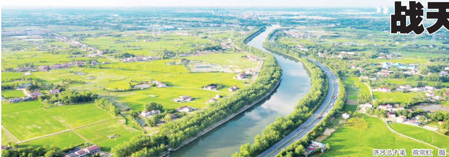
淮河总干渠 蒋常虹 摄
