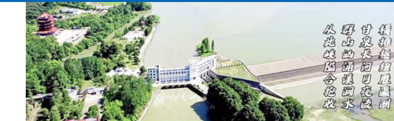
横排头渠首枢纽工程 蒋常虹 摄
