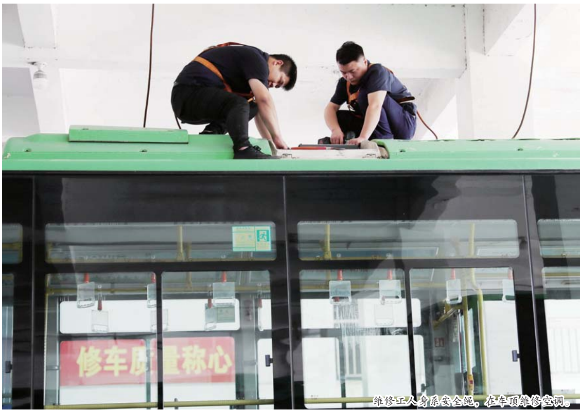
维修工人身系安全带，在车顶维修空调。
