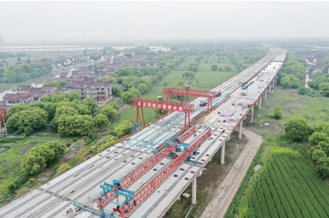
4月25日拍摄的苏台高速公路七都至桃源段ST-QL5标施工现场(无人机照片)。
