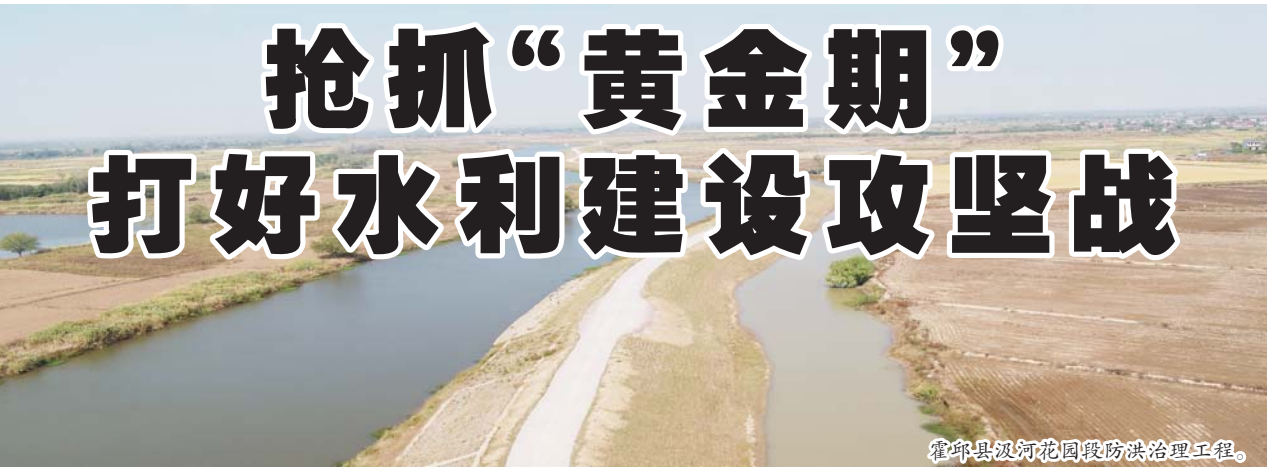
霍邱县汲河花园段防洪治理工程。
