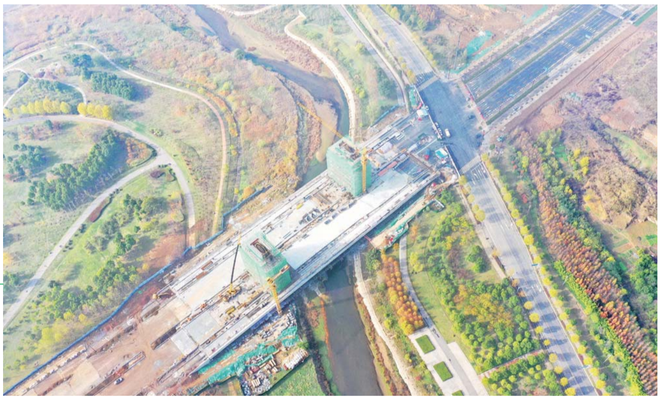
11月20日,城区佛子岭西路跨凤凰河桥及接线工程项目施工现场,桥梁塔柱建设有序推进。据了解,佛子岭西路跨凤凰河桥及接线工程项目,线路全长约800米,包括一座塔高36米的矮塔斜拉桥及东、西岸两个道路,是六安中心路网内环线交通性主干道佛子岭路的重要节点工程。目前施工方正抢抓工期进行桥梁塔柱、桥面铺装及绿化附属工程施工,预计项目主线将于今年底具备通车条件,建成后 will 将缩短主城区与河西新区之间的通行时间,并对推动引领区域经济社会发展起到重要作用。
