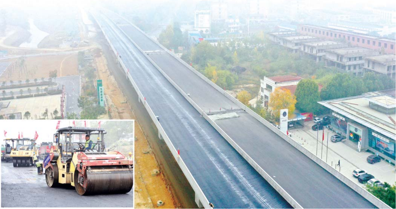
11月11日拍摄的主体工程完工的G312合六界至六安迎宾大道交叉口段快速化改造工程施工现场。大图:和平路与蓝溪路之间,几台压路机正在进行沥青路面摊铺施工(大图)。小图:和平路与蓝溪路之间,几台压路机正在进行沥青路面摊铺施工(小图)。
