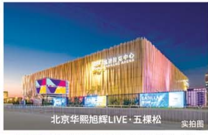
北京华熙旭辉LIVE·五棵松 拥有“双奥场馆”的标志性大型文娱综合体 入选首批国家夜间文化和旅游消费集聚区
