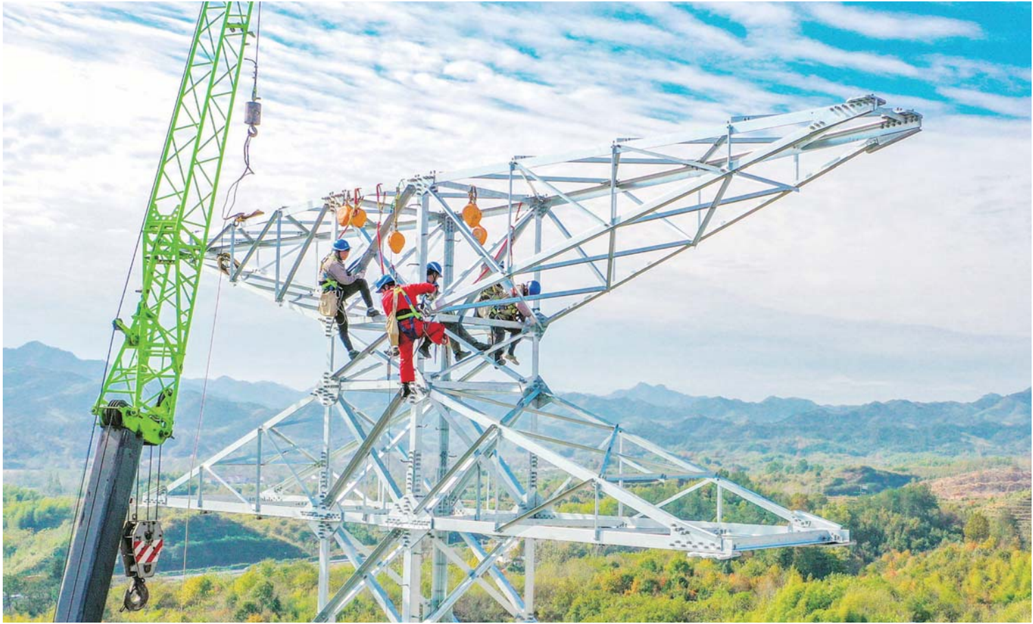
10月25日,国网六安供电公司组织电力施工人员,在220千伏蓝山输变电工程现场组立最后一基输电铁塔。蓝山输变电工程是我市第16座220千伏变电站,也是弥补我市南部山区电网相对薄弱的枢纽变电站,将成为金安区毛坦厂镇等周边多个城镇的主要供电来源。 许婕媚 摄
