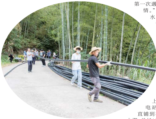
图为引水管架设现场。
