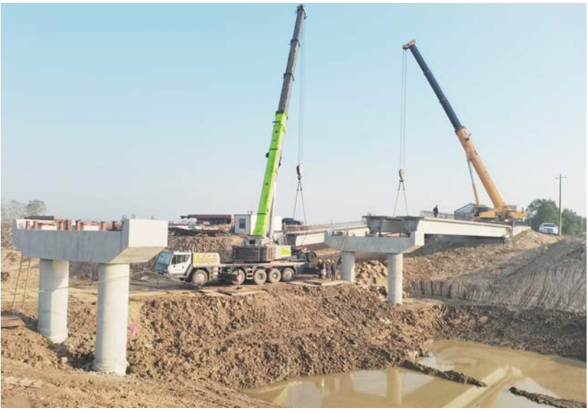
杭埠河治理工程施工。张华涛 摄
