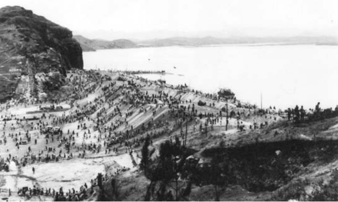
1958年11月,舒城县龙河口水库开始兴建。图为水库施工现场。
