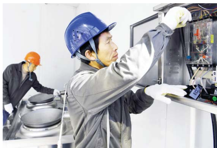
大湾村电力驿站的工人在为村民汪达海家安装安全电厨房。通过推广全电厨房应用，帮助村民逐步实现绿色低碳、经济环保的生活方式。
