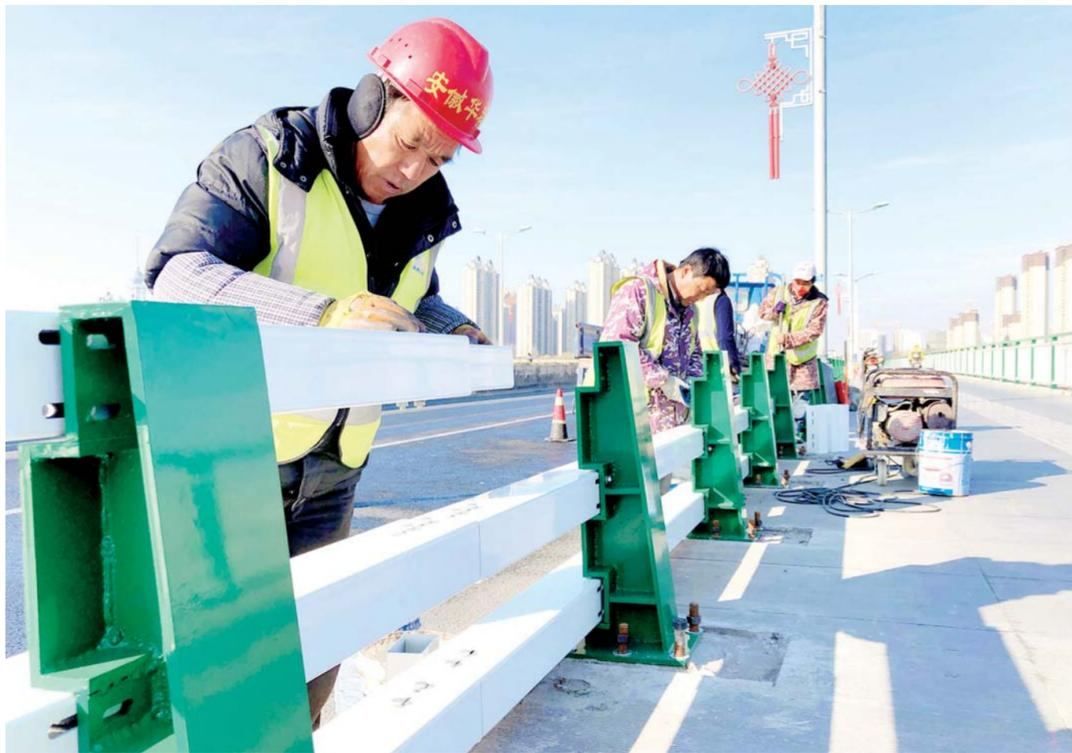
12月20日,工人在城区新安大桥安装防撞护栏。据了解,为进一步提升道路桥梁安全系数,保障市民出行安全和行车安全,近日我市相关部门将对城区解放南路桥、寿春路桥、新安大桥等部分桥梁防撞系统升级改造,根据不同桥梁的自身防护等级通过安装金属立柱式防撞护栏等措施,为城市交通安全保驾护航。
