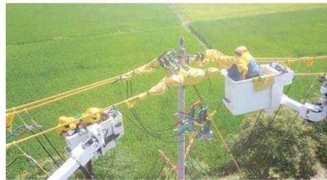
9月8日,伴随着工作负责人的一声令下,叶集供电公司35千伏桥店变10千伏桥新05线五皇支线301开关合闸成功,标志着该线路首次完成旁路带电作业更换柱上断路器。
