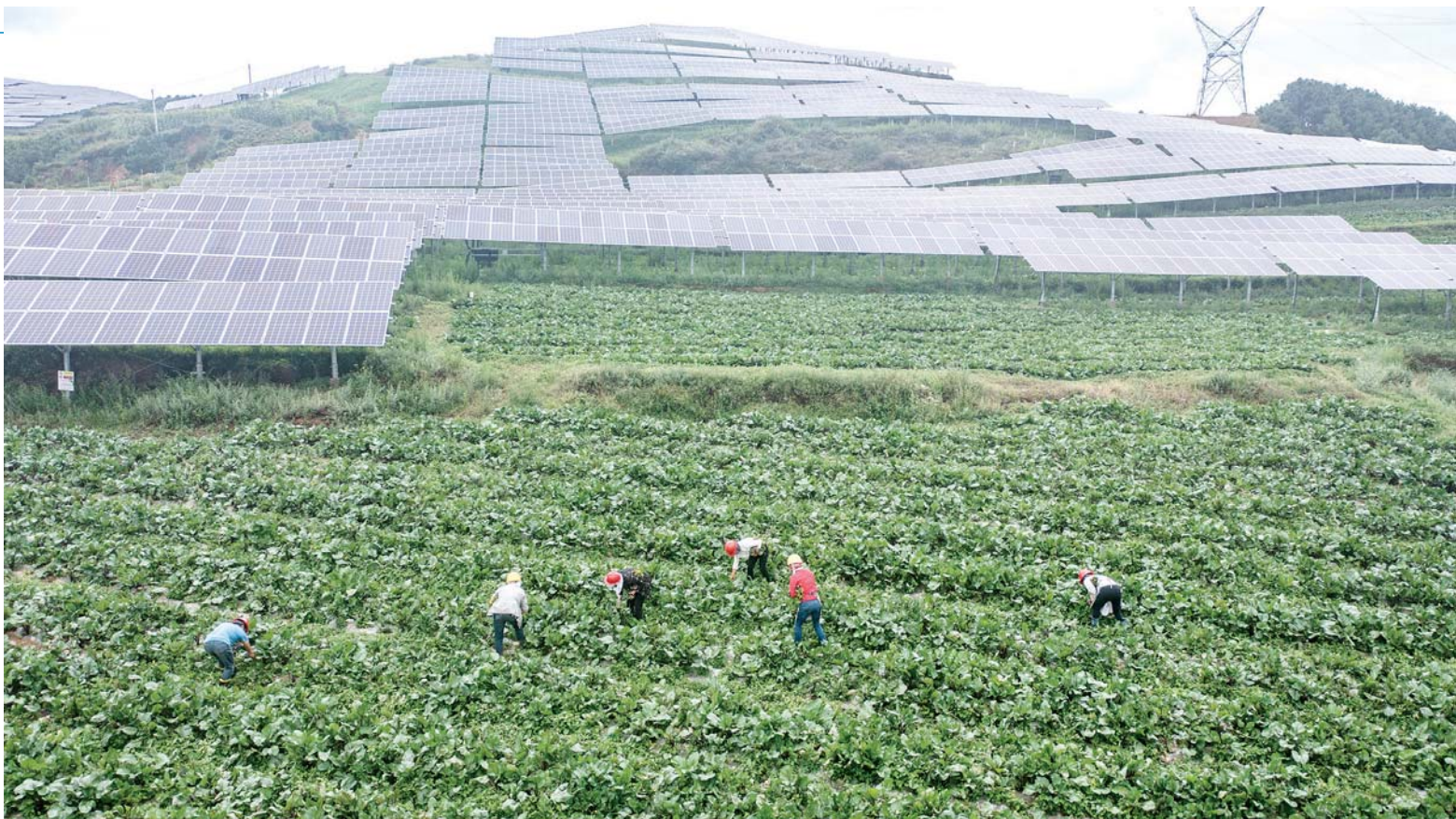
当地村民在仙水窝光伏电站采摘红菜苔（8月24日摄，无人机照片）。在贵州省毕节市威宁彝族回族苗族自治县，光伏板下5000多亩土地种植的农产品进入丰收季，食用菌、红菜苔、白萝卜……一片片光伏板下生机盎然。近年来，国家电投集团贵州金元公司大力推动“农光互补”项目，电站在发电的同时，利用高支架下的土地种植经济价值较高的农作物，带动当地农民增收致富，为实现碳达峰、碳中和目标和助力乡村振兴贡献力量。
