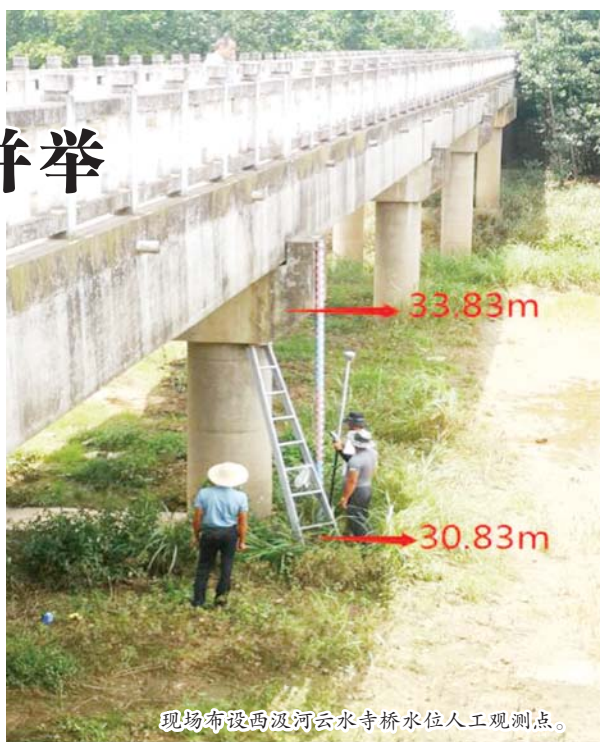
现场布设汲河云水寺桥水位人工观测点。
