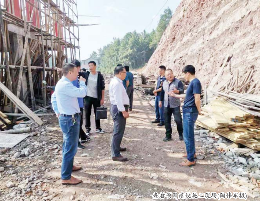
查看项目建设施工现场(陶伟军摄)
