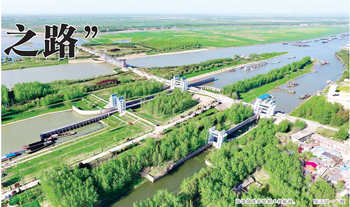
临淮岗洪水控制工程航拍。 张玉良 摄
