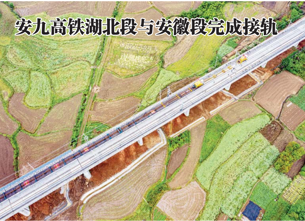
4月26日，中铁十一局建设者在安九高铁温岭岭特大桥进行铺轨作业(无人机照片)。
