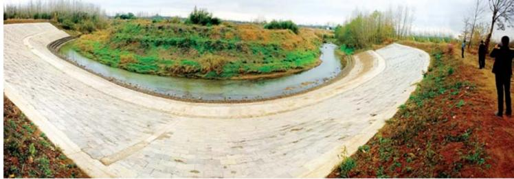
叶集区西汲河治理工程为省灾后水利水毁修复与薄弱环节建设性治理项目，河道综合治理长度约15.08km，对9处防洪薄弱环节进行格宾石笼和预制块护坡防护、部分河道疏浚，新建堤顶防汛道路8km。
