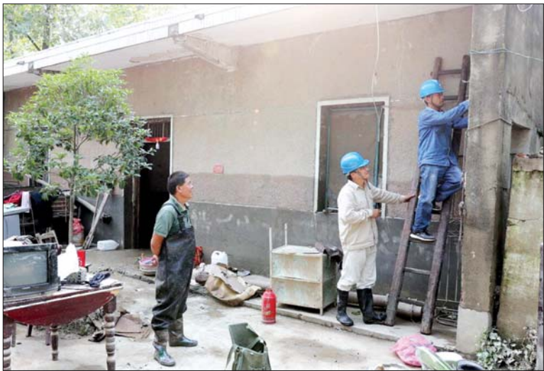
7月20日下午，叶集区姚李镇头道河村，供电部门正在帮助受灾户接通临时用电，保障受灾群众生活。
