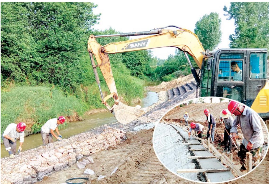
6月8日，叶集区姚李镇双红村油坊组境内的汲河治理项目工程施工现场，一台台大型挖掘机与工人相互配合进行河道护坡、堤坝加固。据了解，为有效治理汲河水患，叶集区通过多方筹措专项资金对涉及辖区洪集镇5个村、姚李镇双红村等村组段汲河，进行岸堤护坡加固、河道疏浚、堤顶防汛道路修建等施工，努力保障沿河群众的生命财产安全。据悉，该工程预计于今年10月底完工，全长约15.08公里。
