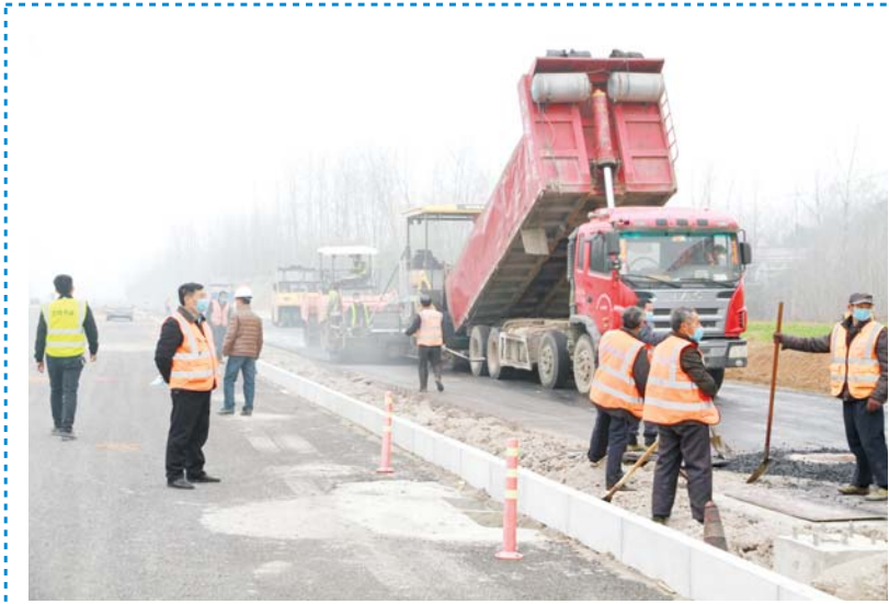
G312六安西至大顾店改扩建项目建设如火如荼。 王梦杰 摄
