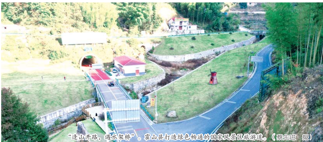
“逢山开路,遇水架桥”。霍山县打造绿色畅通的国家风景区旅游道。(蔡先建 摄)
