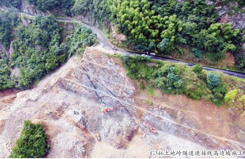
G346土地岭隧道连接线高边坡施工
