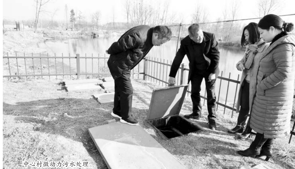
中心村微动力污水处理。
