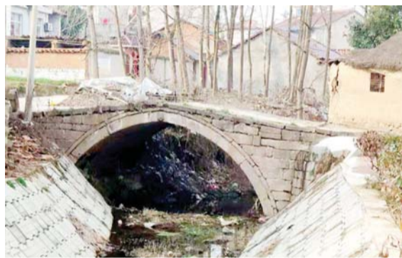
舒城县张母桥南街头的古拱桥“张母桥”（建安子摄于2019年5月）
